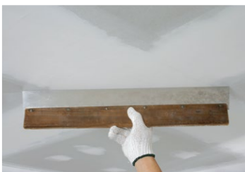
ตรวจสอบระดับงานฉาบรอยต่อสี่แยก
